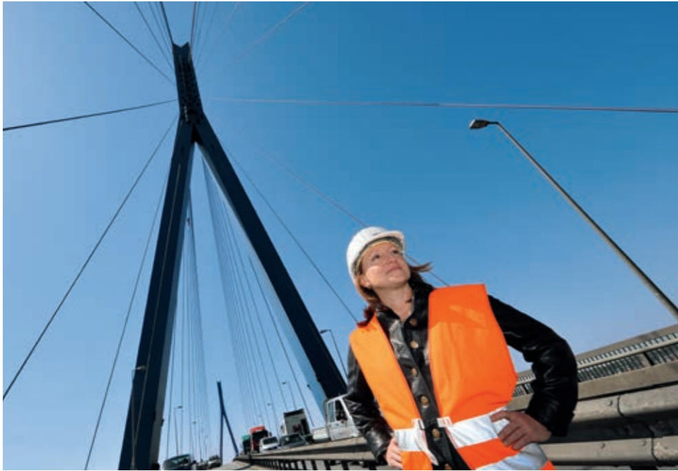
01 Die HPA ist u.a. für die Instandhaltung von über 130 km Straßen zuständig.
