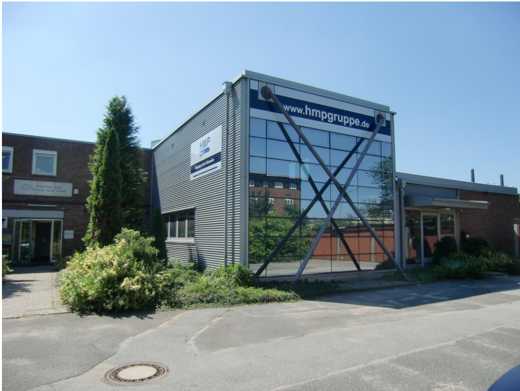
Nebengebäude: Außenansicht (Backsteinbau befindet sich links daneben)
