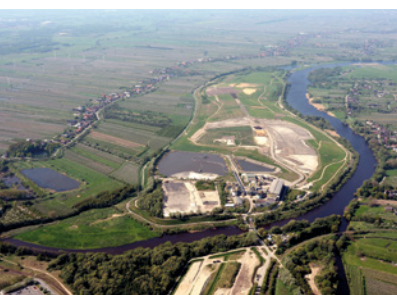
Hamburger Baggergutdeponie Francop mit Behandlungsanlage METHA
