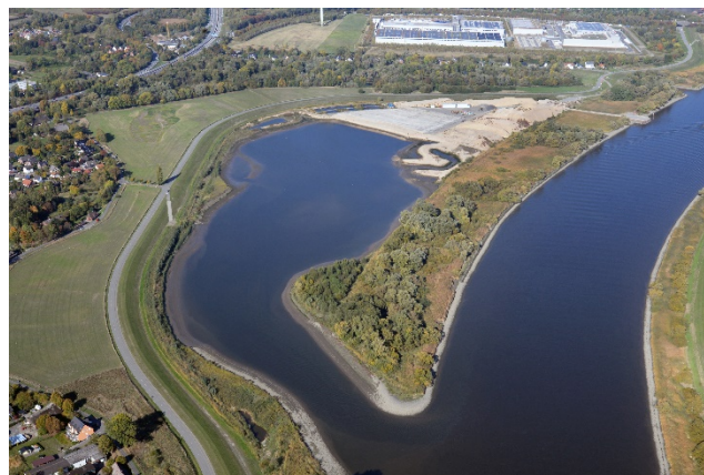
Abb. 24: Flachwassergebiet Kreet-sand im Bau (2019, Luftbild: Holger Weitzel)
