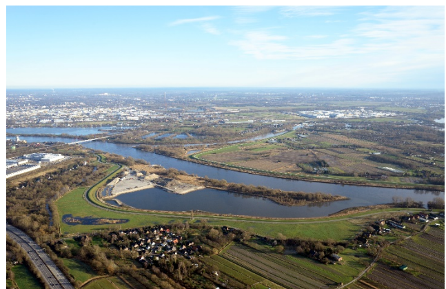
Abb. 20: Flachwassergebiet Kreettsand im Bau.
