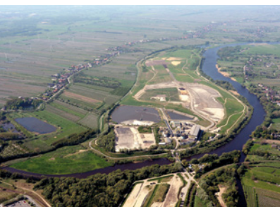
Hamburger Baggergutdeponie Francop mit Behandlungsanlage METHA
