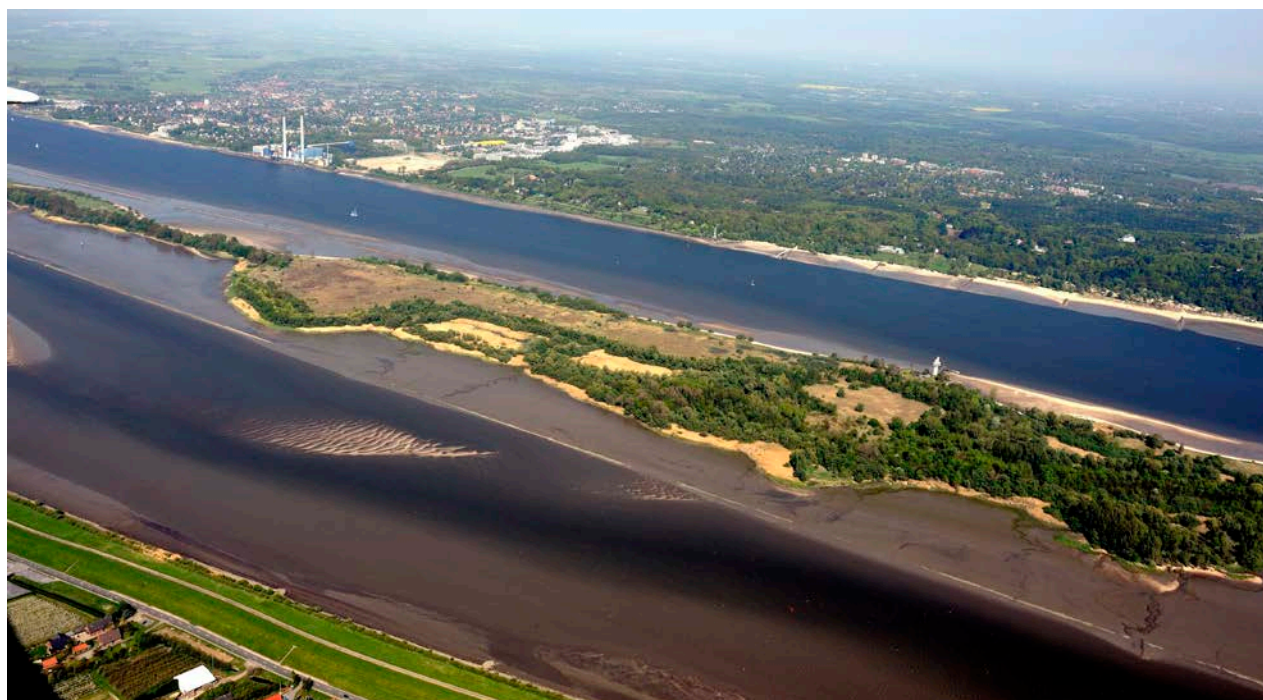
Abb. 1: Bereich der Klappstelle vor der Elbinsel Neßsand (Foto: Falcon Crest, © HPA)
