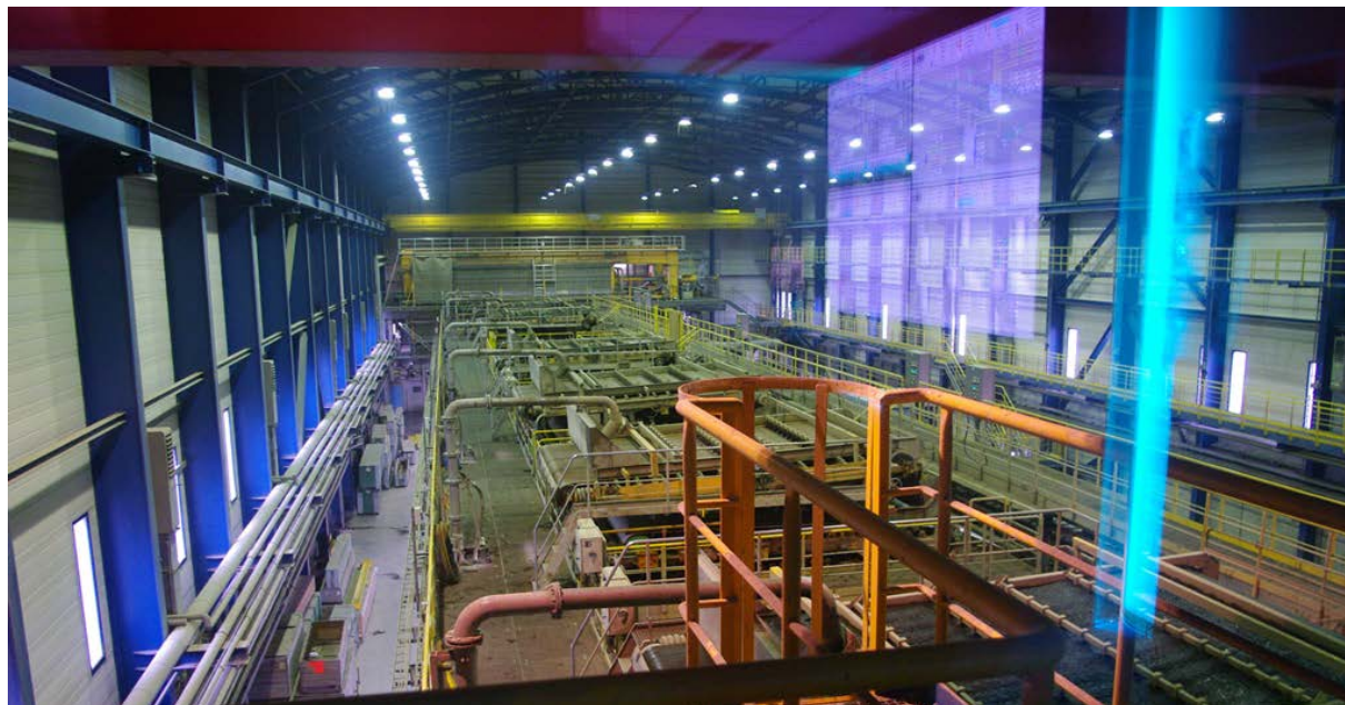
Abb. 15: Behandlung von belastetem Baggergut: Trocknungspressen in der METHA. (Foto: B. Hochfeld, © HPA)
