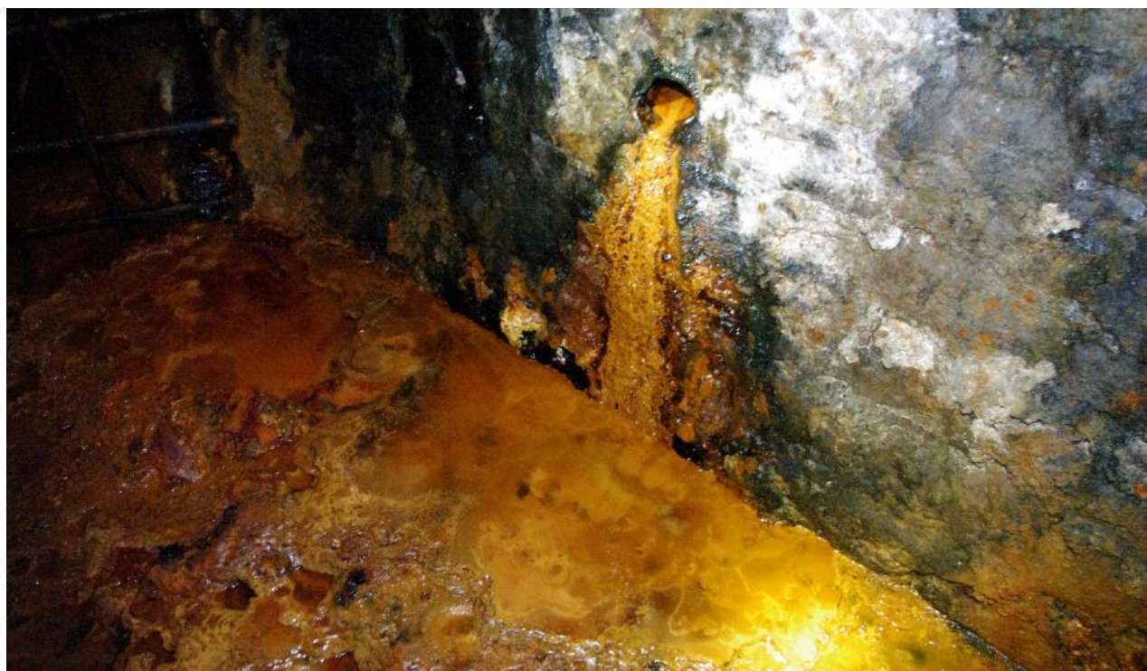
Abbildung 17: Schwermetallhaltige Sickerwässer in einem ehemaligen Silberbergwerk im Erzgebirge. Die Sickerwässer gelangen bislang ungeklärt in die Elbe. (Foto: Boris Hochfeld).
