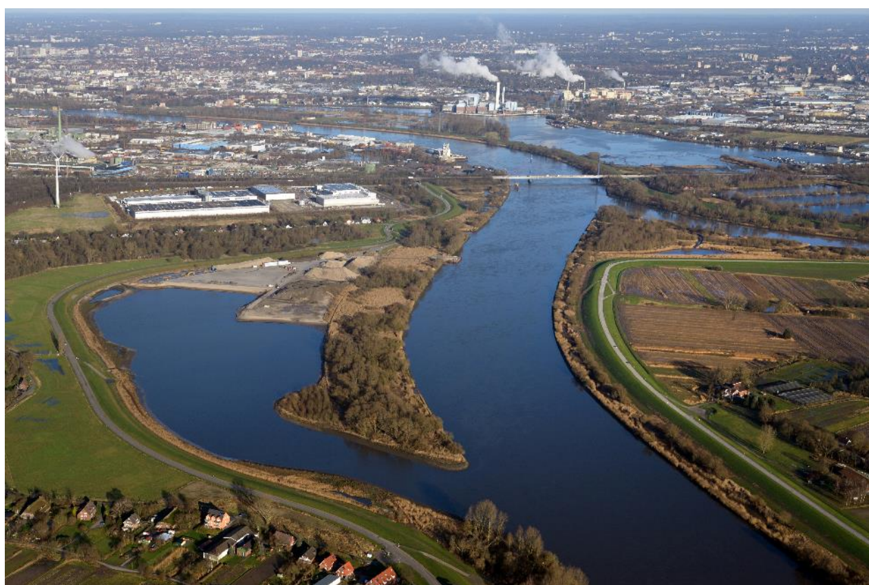
Abbildung 3: Flachwassergebiet Kreetsand im Bau (Foto: Holger Weitzel, 2018).
