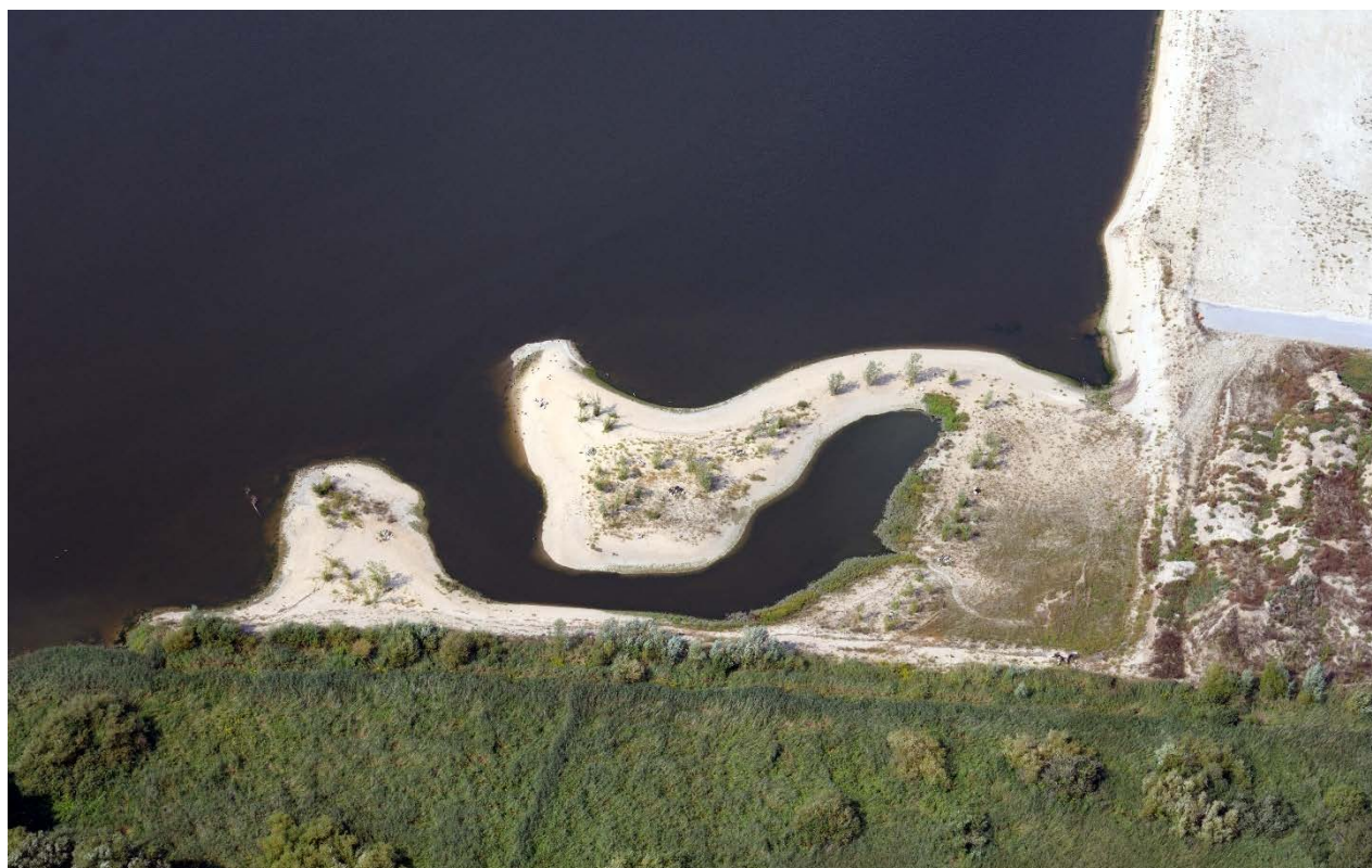
Abbildung 3: Detail des im Bau befindlichen Flachwassergebiets Kreetsand (Foto: Holger Weitzel, 2019).
