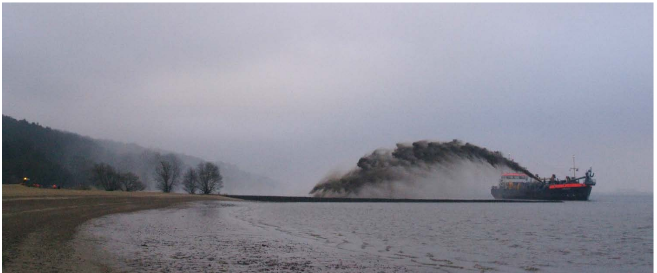
Abb. 1: Strandaufspülung im Rainbow-Verfahren am Falkensteiner Ufer (Foto: B. Hochfeld).
