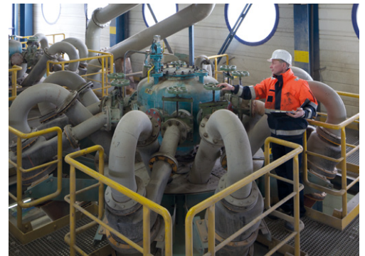
In diesem Hydrozyklon werden Wasser und Sand getrennt.
