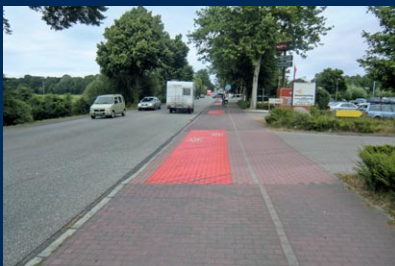
Gewerbezufahrten: Rot eingefärbtes Pflaster erhöht Sicherheit.
