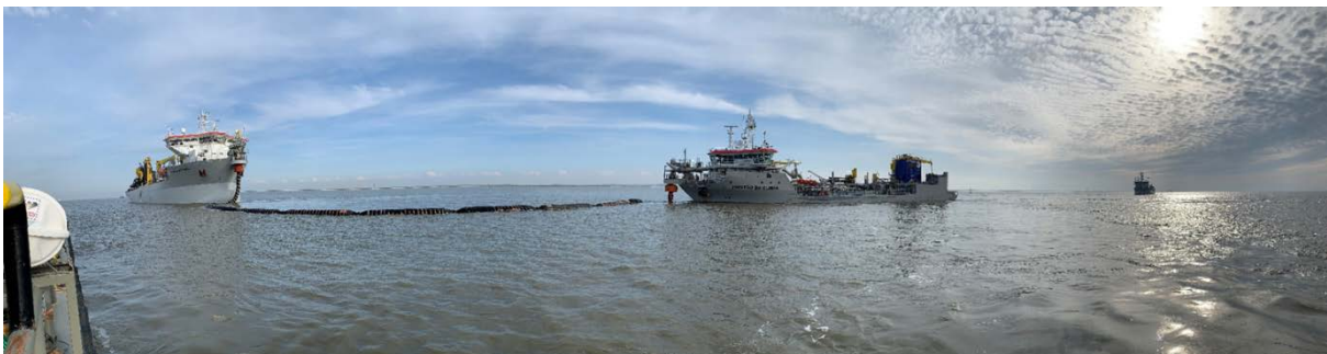
Abb. 1: Übergabe von Ausbaubaggertgut zum Einbau in die Unterwasserablagerungsfläche Neufelder Sand (Foto: Sebastian Sandt).
